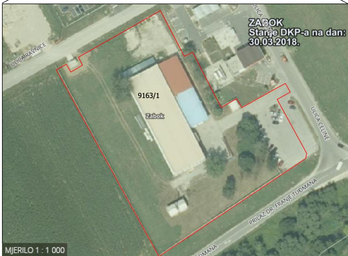
Slika 1-1 Orto-foto snimka lokacije predmetnog zahvata s prikazanim granicama obuhvata zahvata i prilazne ceste do buduće građevine
